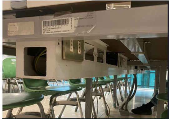
IMAGEN REFERENCIAL BANDEJA DE ELECTRIFICACION
