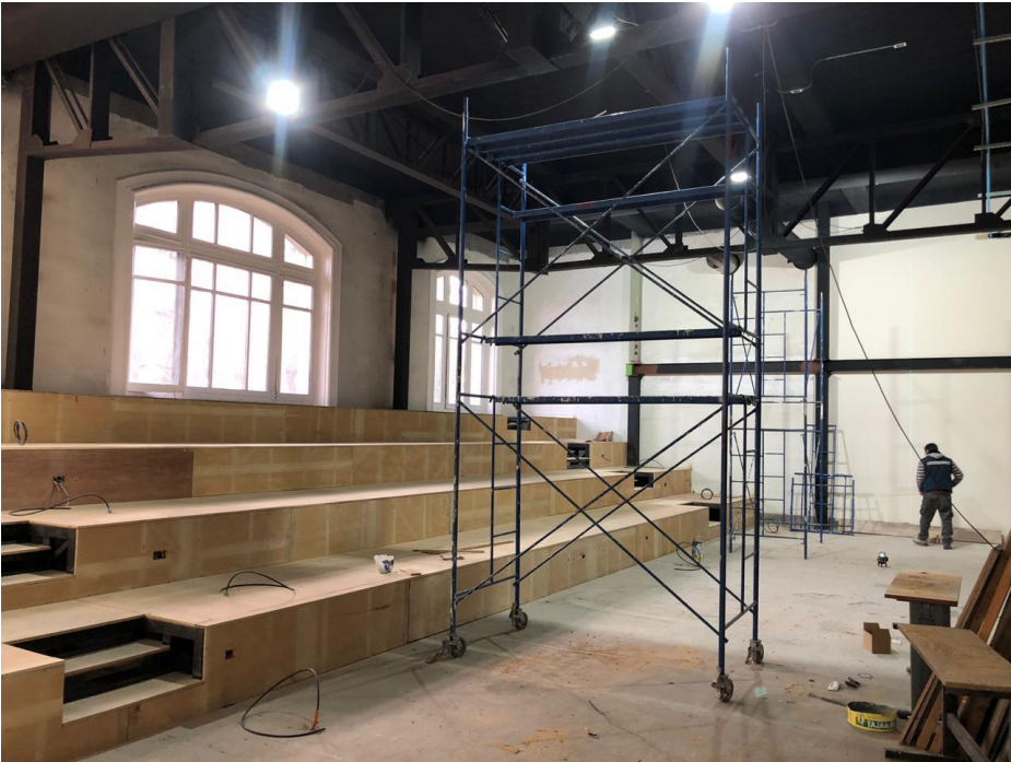
Actualmente el auditorio se encuentra en obra.
